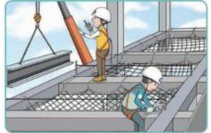
6 안전대 착용 시 안전대 부착설비 설치
